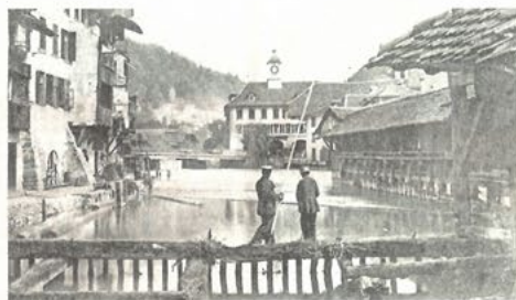
Dieses Foto mit Blick in Richtung Freienhof entdeckte ein Bekannter in einem Antiquitätengeschäft in Athen. Foto: PD/Archiv Markus Krebser
